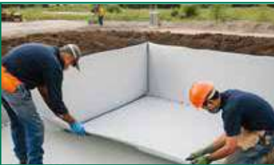
Liner listo para ser instalado
