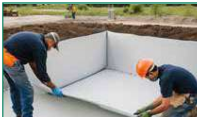
Liner listo para ser instalado
