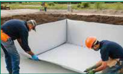
Liner listo para ser instalado
