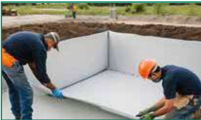
Liner listo para ser instalado
