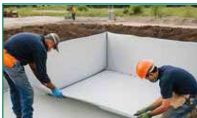
Liner listo para ser instalado
