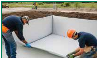
Liner listo para ser instalado
