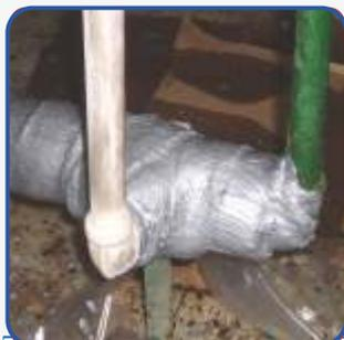
**DESCRIPCIÓN:** Nuestro sistema aislante impermeable RAI, (no asbesto) se realiza en el sitio a partir de tejido de fibra de vidrio moldeado con manta cerámica e impermeabilizado con un tejido de fibra de vidrio siliconado conformando un aislamiento térmico de gran ajuste, excelente resistencia mecánica, durabilidad, alta densidad y baja conductividad térmica.
